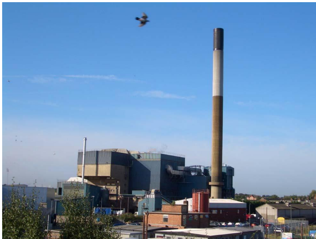
Instalație de incinerare a deșeurilor menajere
